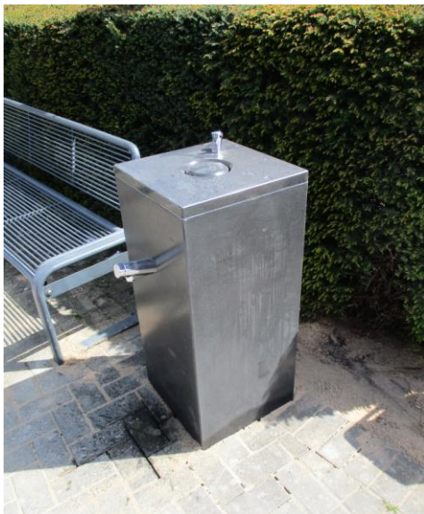
Trinkwasserspender in Herzfeld
