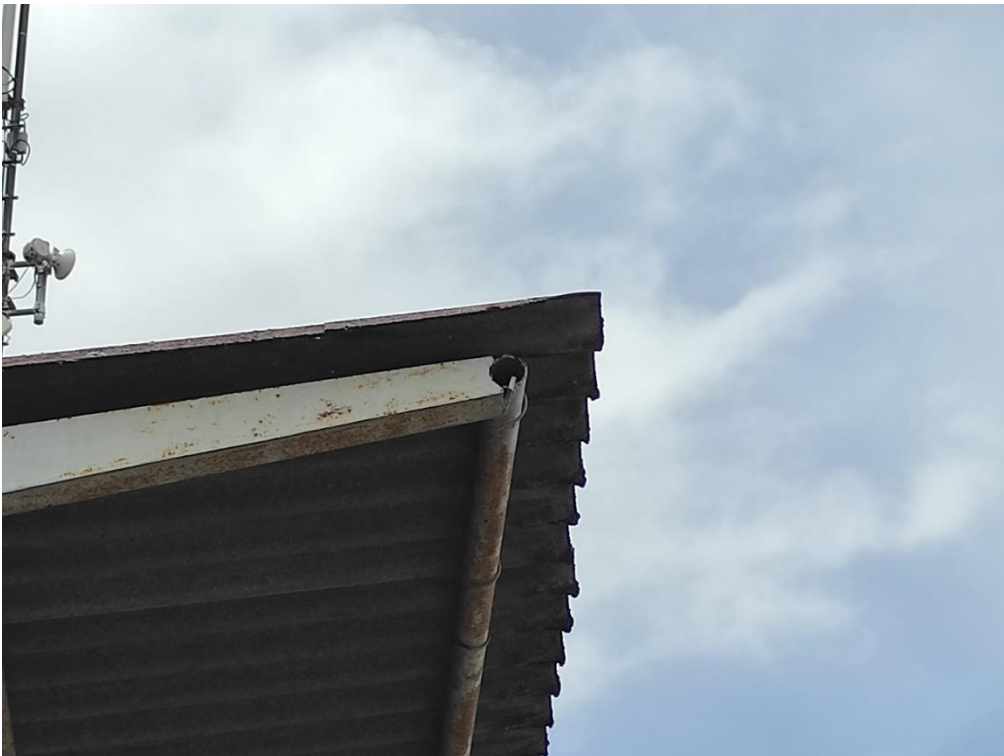
Foto 8: Hohlrohre am Abdach des Lagergebäudes (Fortpflanzungsstätte Kohlmeise)
