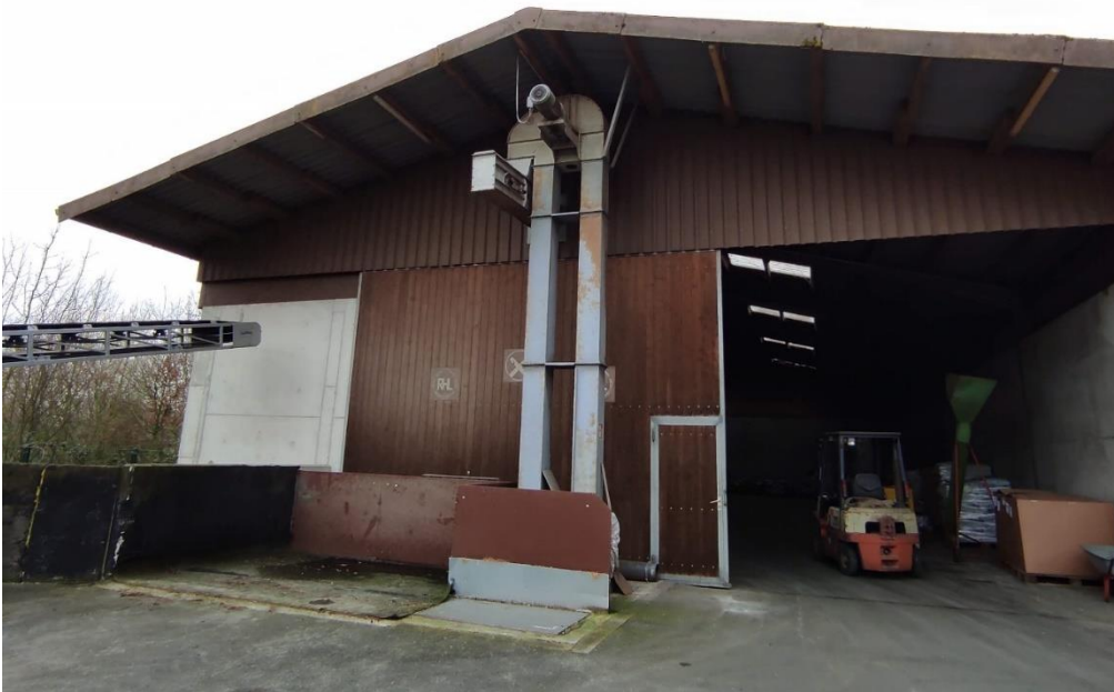
Foto 3: Lagergebäude des Landhandels im Süd-Westen
