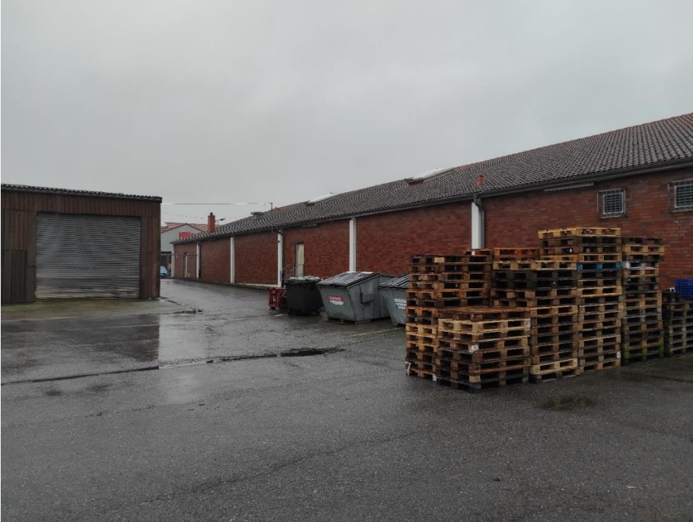
Foto 1: Westseite des Raiffeisen-Marktes
