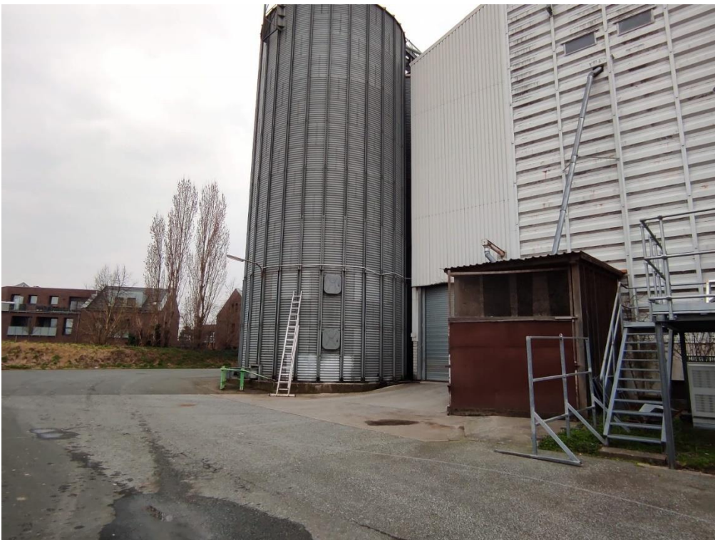
Foto 4: Getreidesilo und Korntrocknungsanlage im Westen des Vorhabenbereiches
